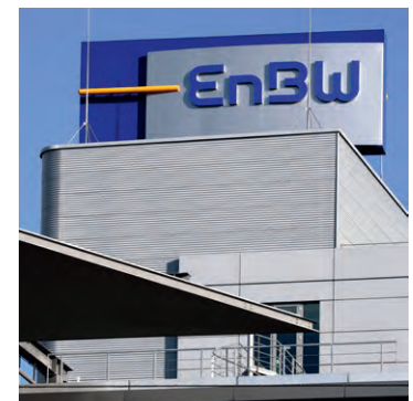
Konzernzentrale der EnBW Energie Baden-Württemberg AG in Karlsruhe
